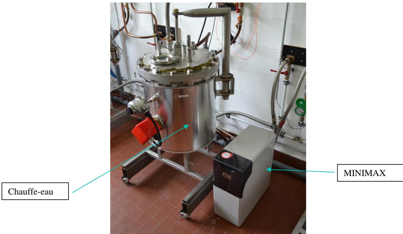
Ces chauffe-eau d'un volume de 50 litres sont alimentés par l'eau de ville sous une pression de 3 bars. L'eau de ville a une dureté calcique d'environ 30°F et une alcalinité d'environ 23°F. L'eau est chauffée et maintenue à 75°C.
